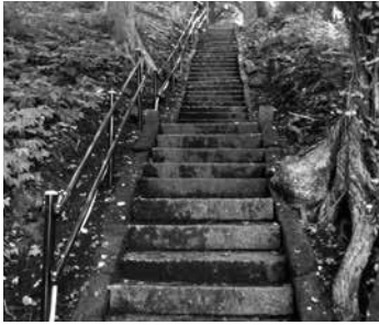
上) 手すり設置作業の様子 下) 新設した手すり
