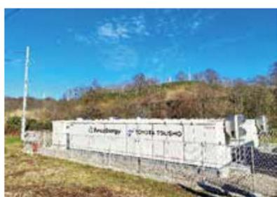
蓄電池システム (出力 1,000kW、容量 3,000kWh)
