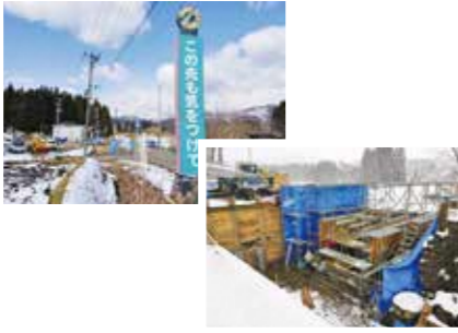
↑界橋の復旧工事の様子
