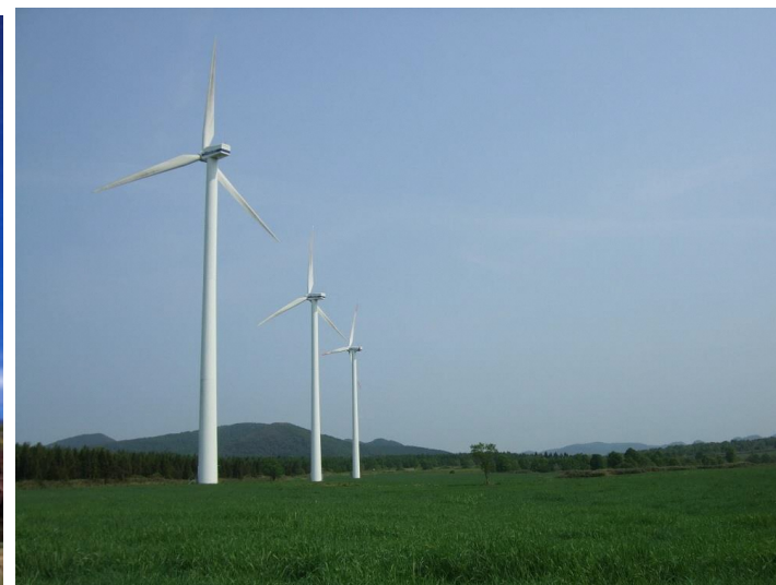
田代平風力発電所
