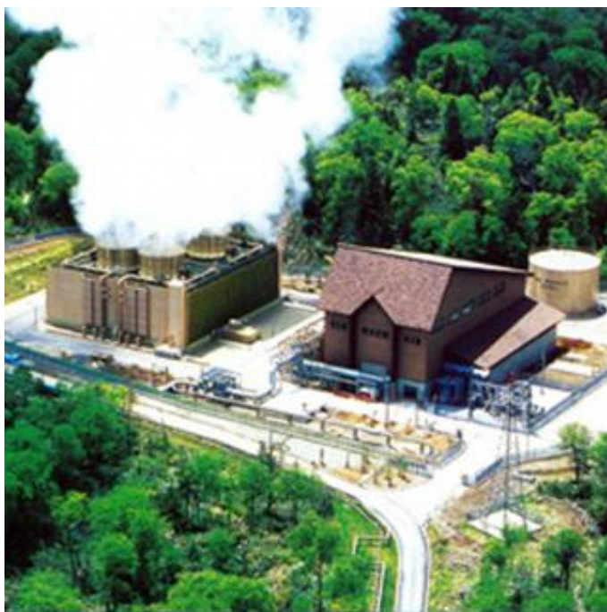
澄川地熱発電所
