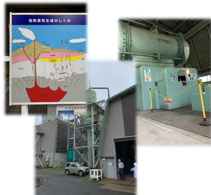
↑ 三菱マテリアル所有の大沼地熱発電所を見学
