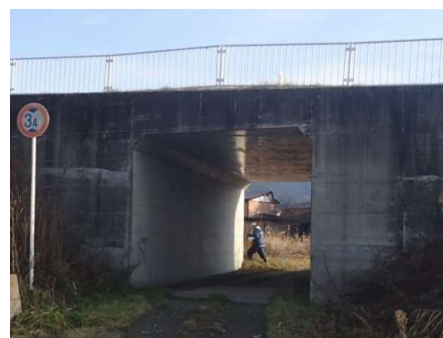
庁舎東町1号橋(橋長 4.9m, 1994 年架設)
