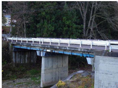
長内橋(橋長 21.1m, 1959 年架設)
