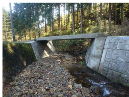
和志橋(橋長 7.8m, 2018 年架設)
