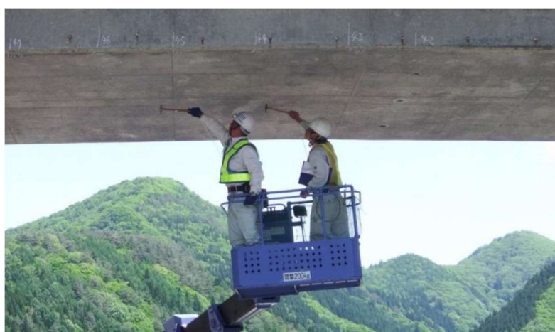
写真-1 橋梁点検状況
