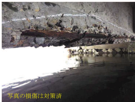
鉄筋露出（主桁）
