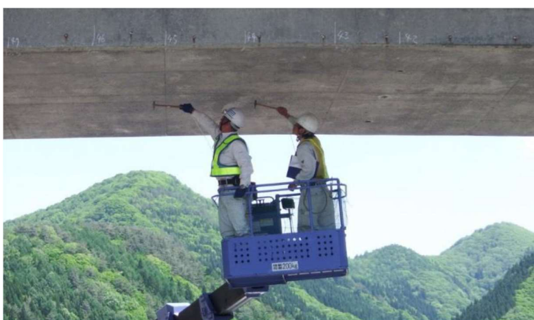
写真-1 橋梁点検状況
