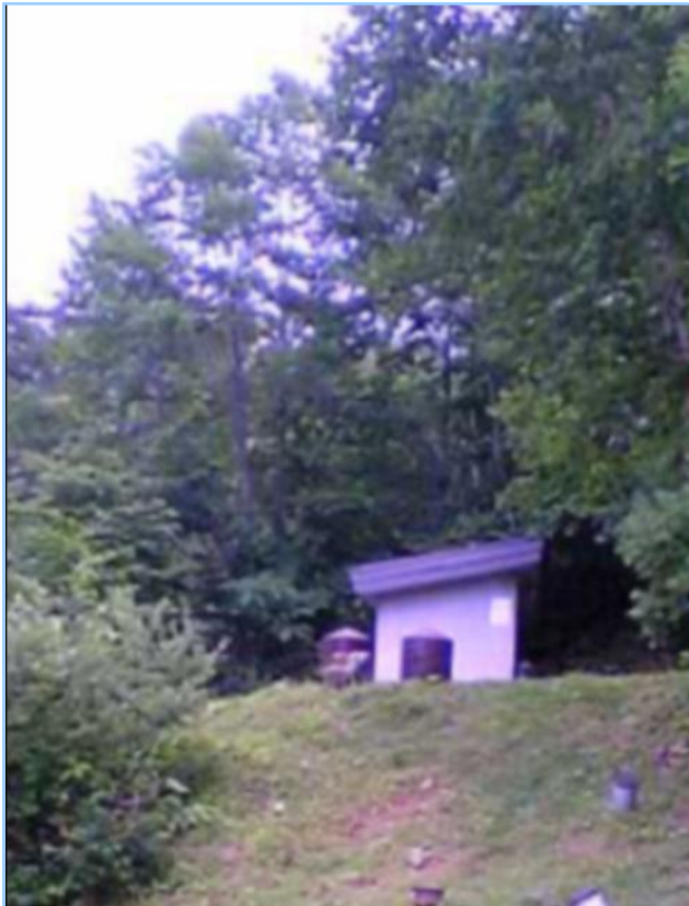
春の後生掛配水池
