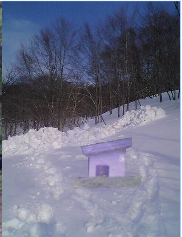
冬の後生掛配水池
