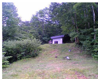
後生掛系 後生掛配水池
