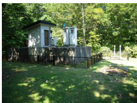
水沢系 切留平配水池
