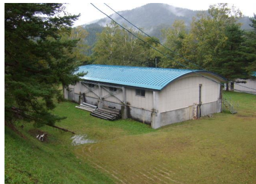
十和田浄水場
