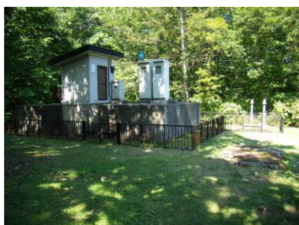
水沢系 切留平配水池
