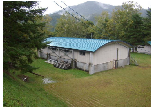
十和田浄水場
