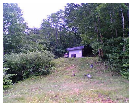
後生掛系 後生掛配水池
