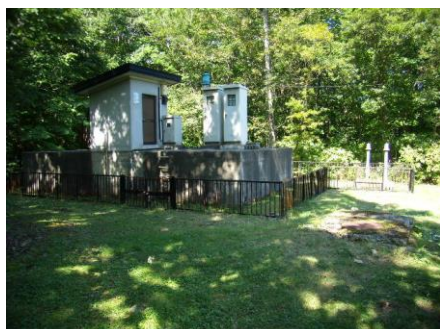
水沢系 切留平配水池
