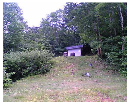
後生掛系 後生掛配水池
