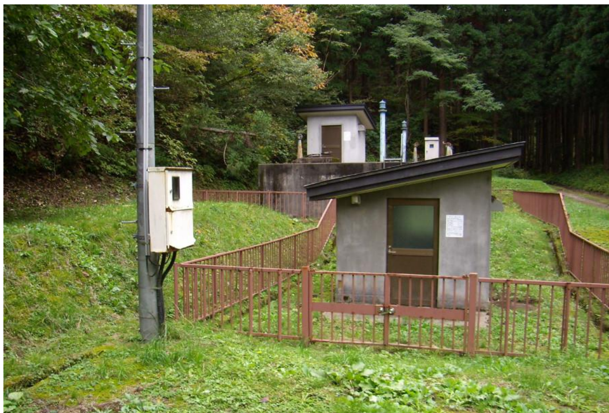
尾去沢系 土深井配水池
