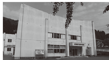
旧八幡平市民センター
