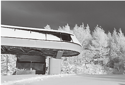
花輪スキー場リフト監視施設
