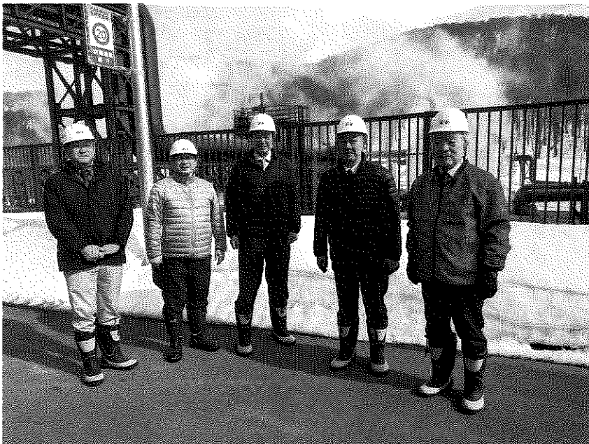
山葵沢地熱発電 施設
