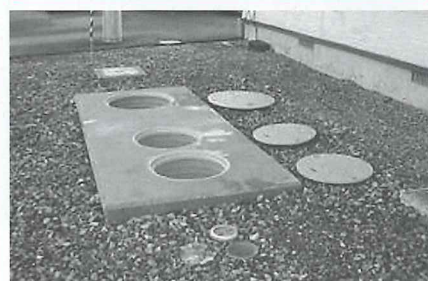
生活排水と尿をあわせて処理する合併処理浄化槽
