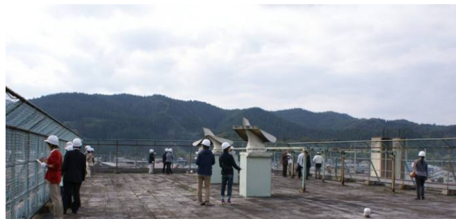
解体中の屋上から敷地を視察
