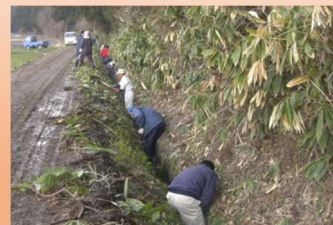
水路の泥上げ
