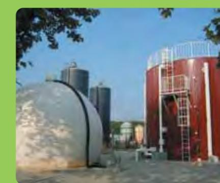
くすまき高原牧場内の牛の排せつ物を発酵させてメタンガスを抽出し、発電ならびに熱回収を行うシステム。畜ふんの適正管理を主な目的として導入したもので、発生電力および熱はプラント内の負荷で消費しています。
