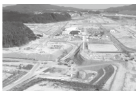
大規模なかさ上げ工事による市街地造成
