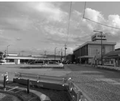
整備工事が進む鹿角花輪駅前広場
