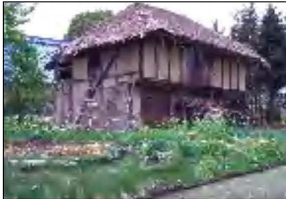
外壁が裸木造の例
