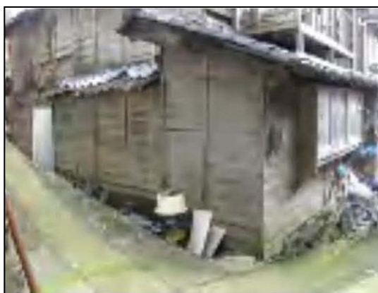
外壁が裸木造の例
