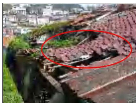
柱、梁の破損や変形が著しく崩壊の危険がある例
